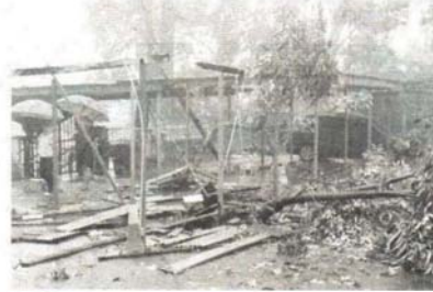
LALUAN pejalan kaki berbumbung di Sekolah Kebangsaan Bandar Baru Selayang, Selangor yang rosak teruk ditimpa pokok. - IHSAN PEMBACA
